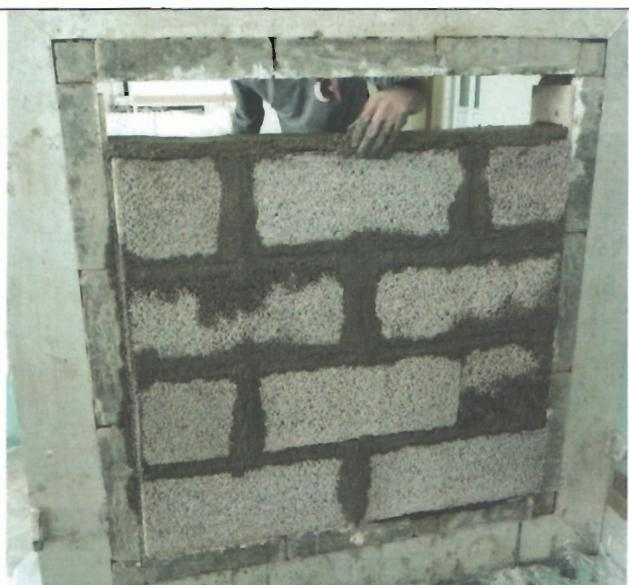
شکل ۳: اجرای دیوار با بلوک‌های سیمانی لیکا و استفاده از ملات
